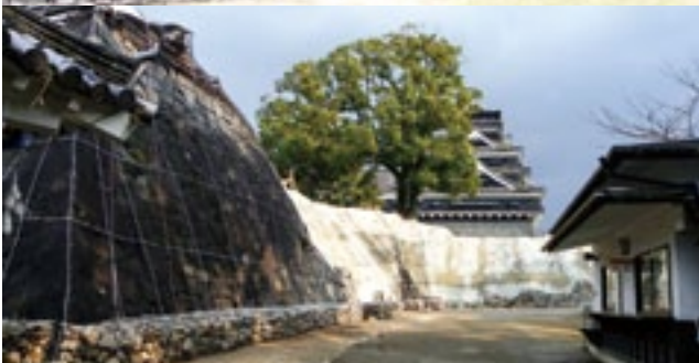
熊本城 上：施行中の様子 下：施工後の石垣
